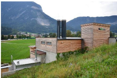
Das Biomasseheizwerk Rotholz wurde 2009 von Bioenergie Tirol Nahwärme GmbH errichtet. Das Werk verfügt über einen 3.000 KW Biomassekessel mit nachgeschaltetem Elektrofilter sowie einer Rauchgaskondensationsanlage zur Wärmerückgewinnung. 2015 wurde die Anlage um einen 1.000 kW Biomassekessel mit einer weiteren Lagerhalle erweitert. Über das rund 5 km lange Fernwärmenetz werden aktuell 49 private und gewerbliche Abnehmer
