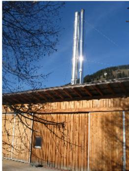
Zwei Biomassekessel mit einer Leistung von 150kW und 750 kW versorgen 17 Kunden im Ortsgebiet von Oberau. Die Anlage ist seit 2001 in Betrieb.
