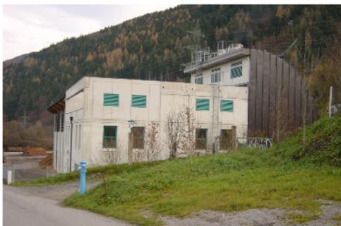
Das Biomasseheizwerk in Stams ist seit Oktober 1998 in Betrieb. Die Kesselleistung beträgt 2.500 kW, die erzeugte Energie im Jahr 2015 betrug ca. 8 MWh. Die Anlage versorgt ca. 80 Kunden mit Wärme.
