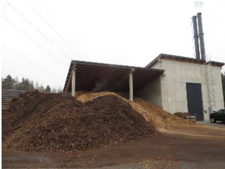
Die Kesselleistung der Bio Wärme Fulpmes/Telfes beträgt 1.700 kW. Die Anlage ist mit Elektrofilter und Rauchgaskondensation ausgestattet. Die Netzlänge beträgt ca. 7 km. In Summe werden ca. 70 Kunden versorgt, größter Abnehmer ist das Freizeitzentrum StuBay.
