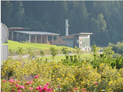
Das Heizwerk Söll wurde im Jahr 2001 errichtet und kontinuierlich ausgebaut. Der Biomassekessel hat eine Leistung von 2500 KW. Weiters besteht die Anlage aus Elektrofilter und Kondensationsanlage. (Leistung 800kW) Ein Teil der Abwärme wird zur Trocknung der Hackschnitzel verwendet. In Summe werden ca. 150 Kunden bei einer Netzlänge von ca. 10500 m versorgt.
