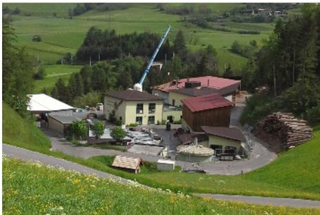
Im Heizwerk Mühlbachl sind zwei Biomassekessel mit 1.400 kW und 600 kW installiert. Die Netzlänge beträgt ca. 7 km. In Summe werden ca. 110 Kunden versorgt.
