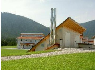
Die Obsteig nahwaerme.at Energiecontracting GmbH & CoKEG wurde 2003 errichtet. Die Kesselleistung beträgt 440 kW, in Summe werden 44 Kunden mit Wärme versorgt. In Obsteig ist zusätzlich eine thermische Solaranlage mit einer Kollektorfläche von 115 m<sup>2</sup> realisiert.
