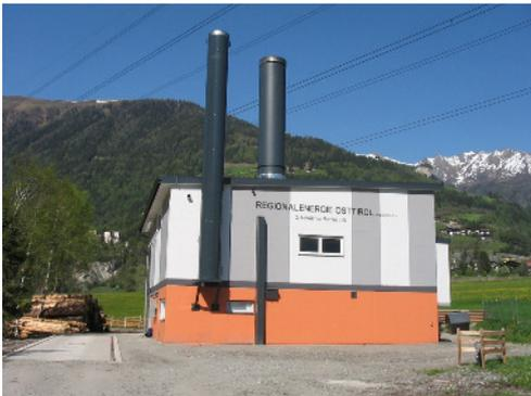
Die Regionalenergie Osttirol reg.Gen.m.b.H. errichtete 2004 das Nahwärmeprojekt „Ortswärme Matri“ und versorgt seitdem den Ortskern der Marktgemeinde Matri i. O. Die Kesselanlage besteht aus einem 3000 kW Holzessel. Die Energie wird über ein ca 9,5 km langes Netz an 108 Übergabestationen und 132 Kunden mit einem Gesamtanschlusswert von 7.665 kW geliefert.
