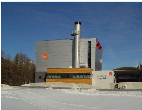
Im Heizkraftwerk der Biowärme Längenfeld werden umweltfreundliche Fernwärme und Strom erzeugt. Über ein 18 km langes Fernwärmenetz werden Haushalte und Betriebe sowie die Therme "Aquadome" versorgt. Das Heizkraftwerk besteht aus einem Biomassekessel, einem ORC-Prozess und einer Rauchgasreinigungsanlage mit integrierter Rauchgasentschwadung. An die 65.000 Schüttraummeter Biomasse-Brennstoffe werden jährlich eingesetzt.
