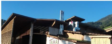
Die Biomassewärmerversorgung Obermüller wurde 2011 errichtet und versorgt ca. 20 Gebäude im Ortsgebiet von Kirchberg mit Wärme. Die Kesselleistung der beiden Biomassekessel beträgt in Summe 1.500 kW.
