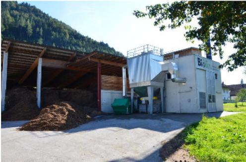
Das Biomasseheizwerk Rotholz wurde 2007 von Bioenergie Tirol Nahwärme GmbH errichtet. Das Werk verfügt über einen 1.500 KW Biomassekessel mit nachgeschaltetem Elektrofilter. Über das rund 1 km lange Fernwärmenetz wird das Schuldorf der LLA Rotholz, die Bundesanstalt für Alpenländische Milchwirtschaft und die LK Tirol (Samendepotstelle) mit Wärme versorgt.
